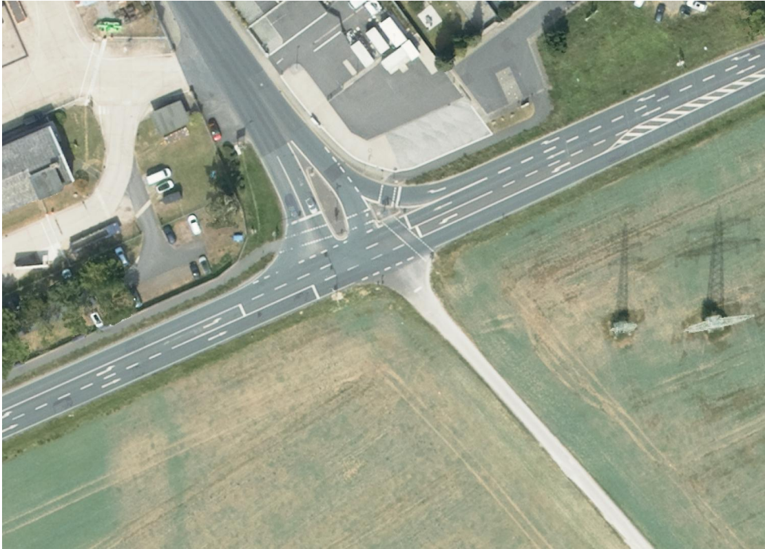
Kreuzung Darmstädter Straße / Industriestraße
