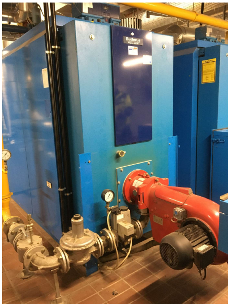
Gaskesselanlage (1,1 + 1,4 MW, Bj. 1999)
