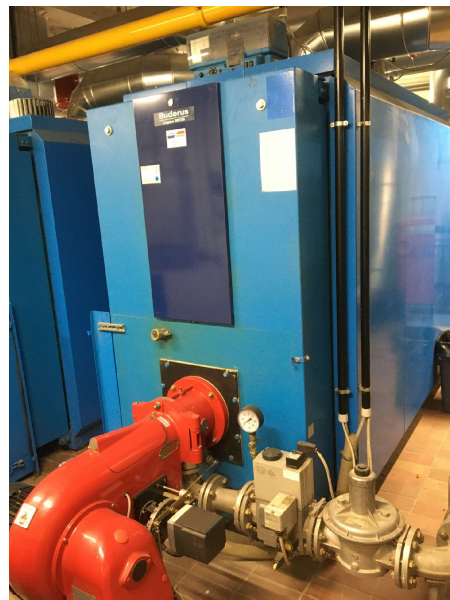
Gaskesselanlage (1,1 + 1,4 MW, Bj. 1999)
