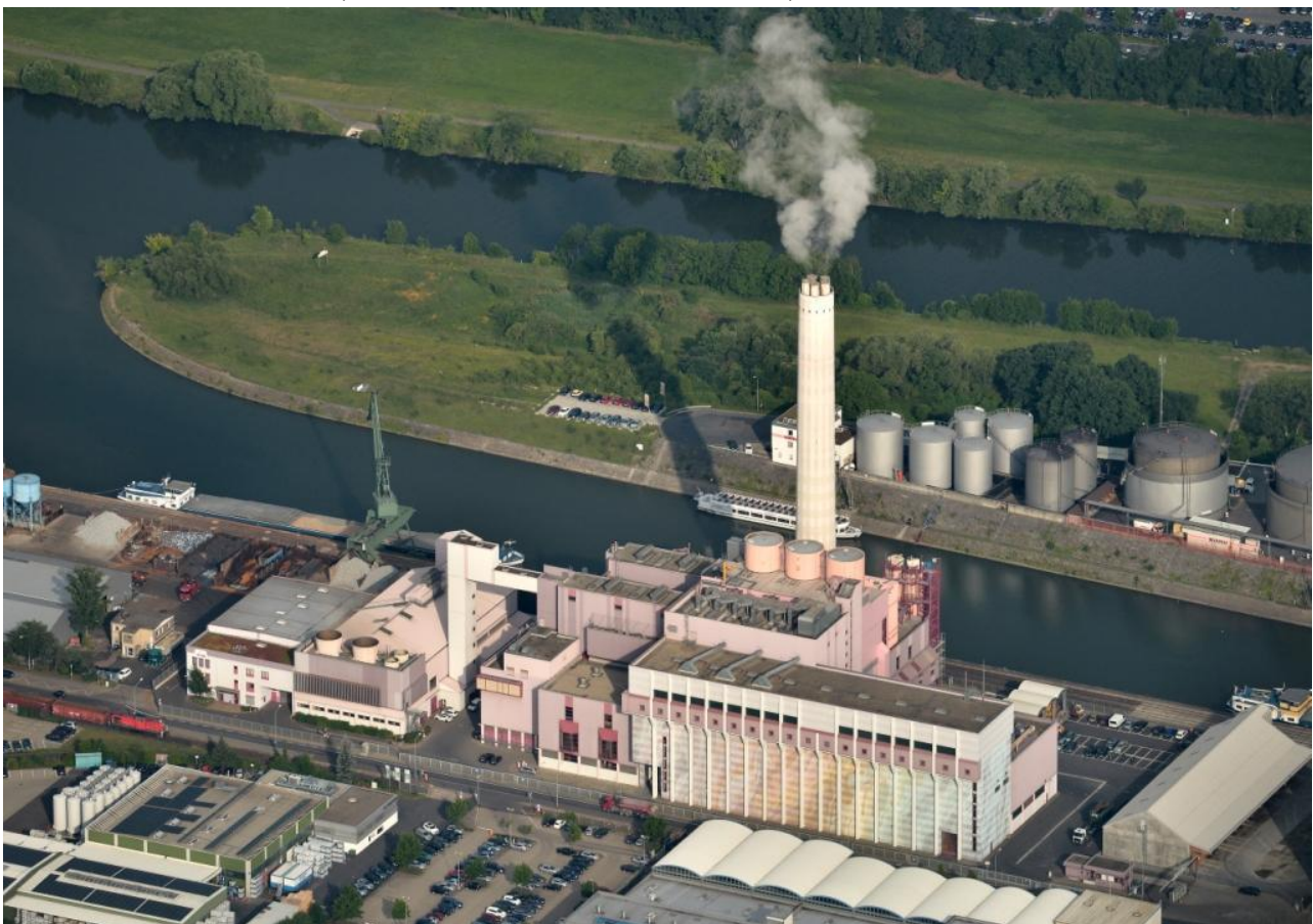
Müllheizkraftwerk des GKS (Gemeinschaftskraftwerk Schweinfurt)
